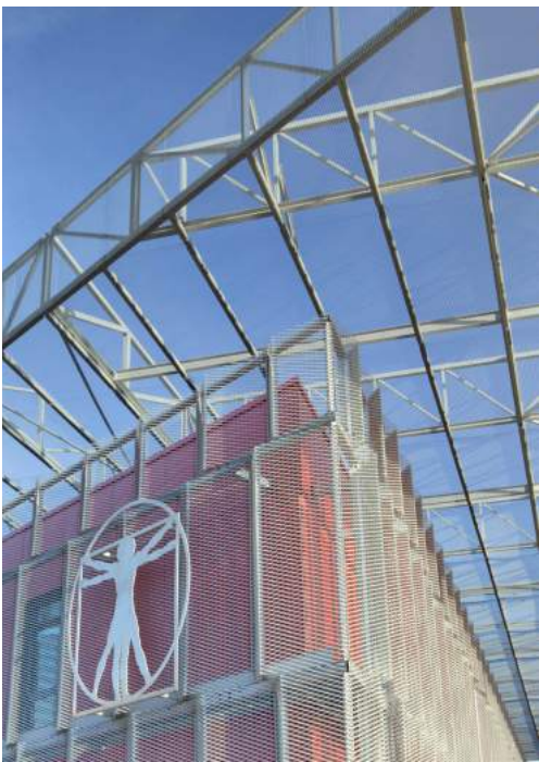
22. Détail de la résille métallique
